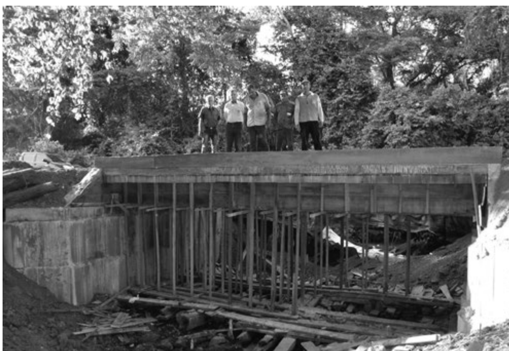
Em menos de dois meses, o governo municipal recuperou quatro pontes de madeira e construiu uma de concreto
