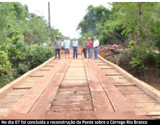
No dia 07 foi concluída a reconstrução da Ponte sobre o Córrego Rio Branco
