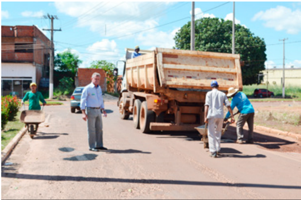
Doze toneladas de material asfáltico foram utilizados para mais uma operação tapa buracos
