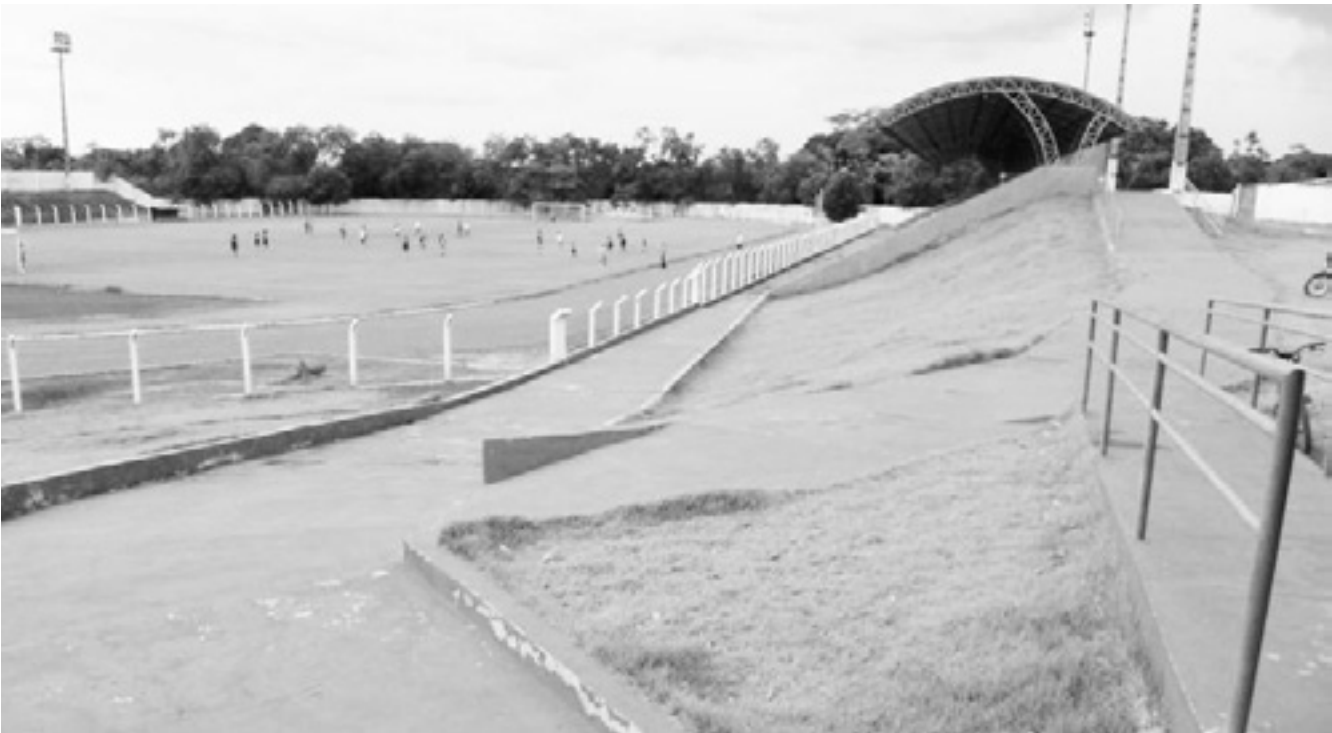
Estádio está interditado desde o dia 29 de fevereiro de 2013
