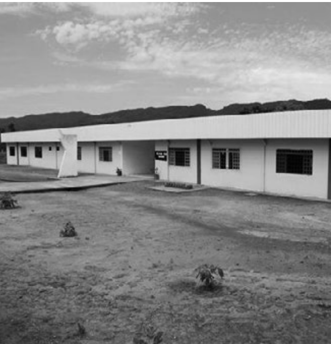
A obra compreende a todas as salas de aula, banheiros e outras instalações
