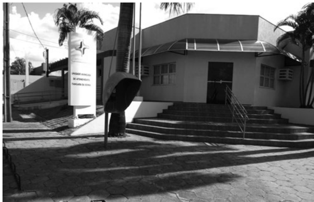
Instalações já estão prontas para o funcionamento da unidade a partir de janeiro do próximo ano
