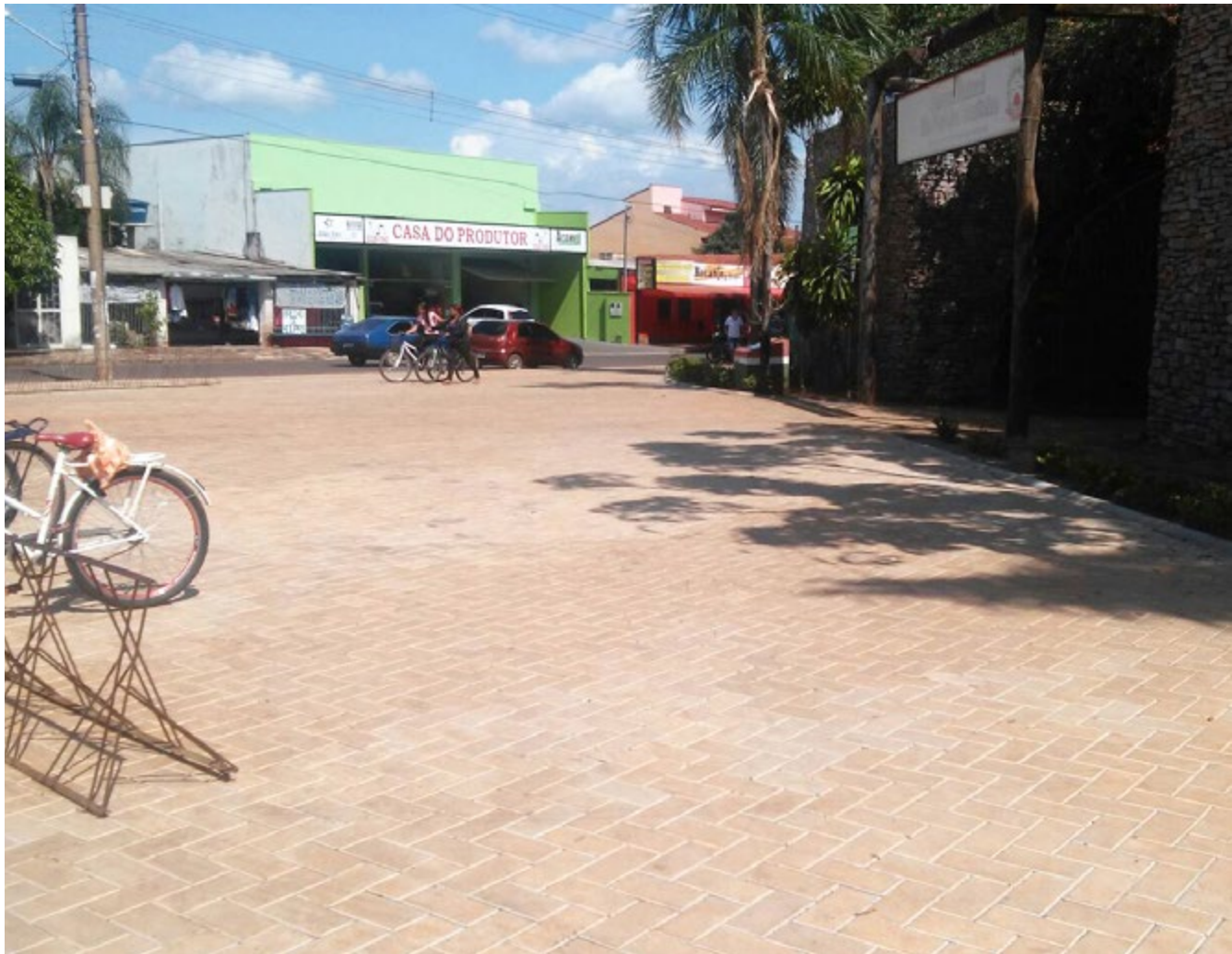
Obra está quase 100% concluída. Últimos ajustes de acessibilidade estão sendo realizados
