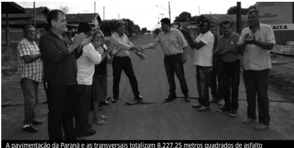
A pavimentação da Paraná e as transversais totalizam 8.227,25 metros quadrados de asfalto
