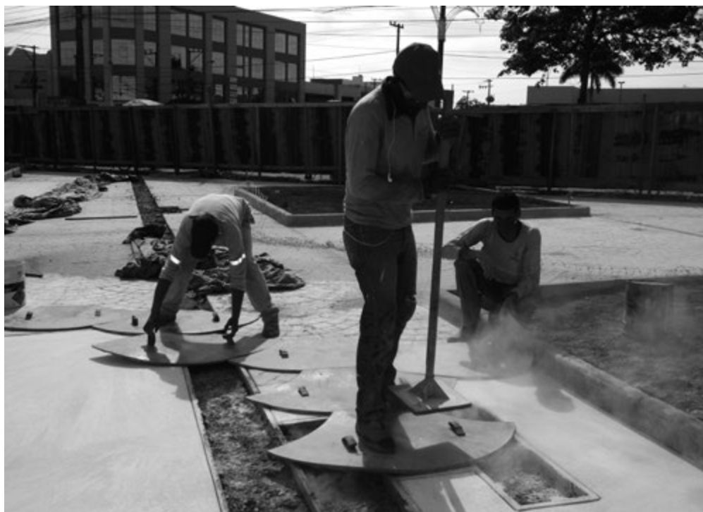
Cerca de 900 metros quadrados de piso já estão prontos
