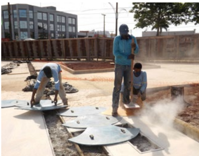
Cerca de 900 metros quadrados de piso já estão prontos
