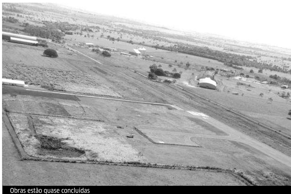
Obras estão quase concluídas
