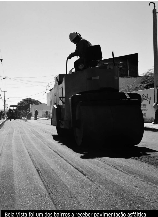
Bela Vista foi um dos bairros a receber pavimentação asfáltica
