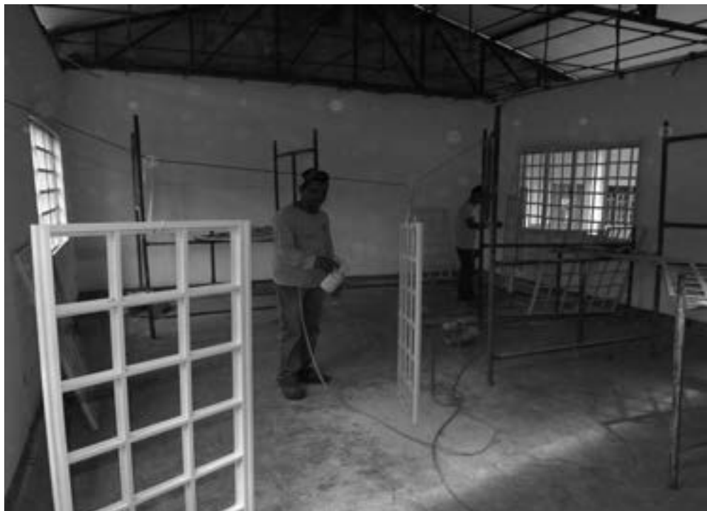
Obra está em fase de acabamento
