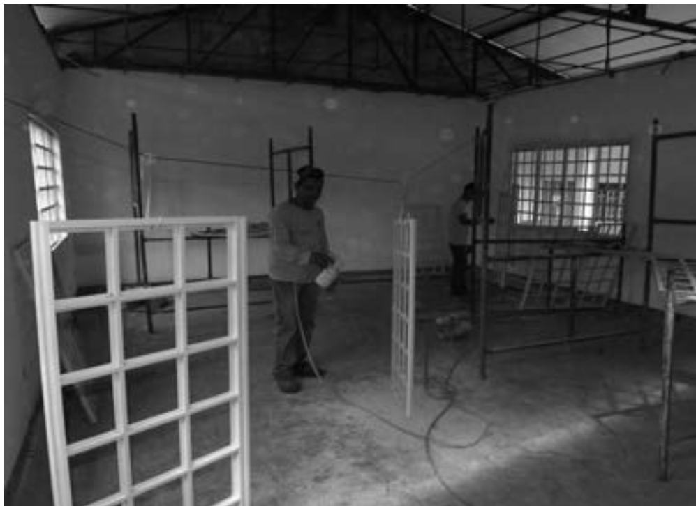
Obra está em fase de acabamento
