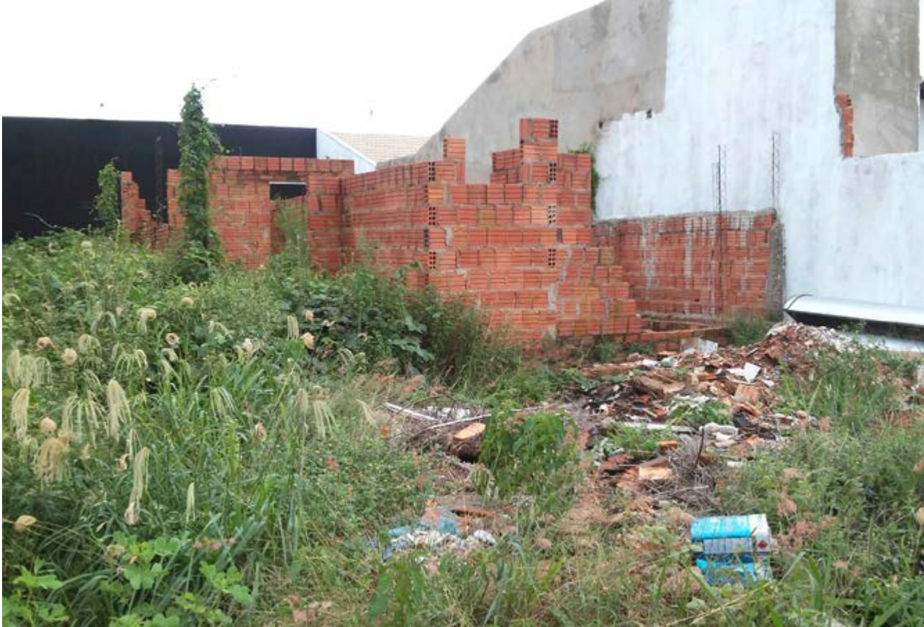
Vários tipos de lixos fazem parte do cenários de várias construções abandonadas em Tangará da Serra
