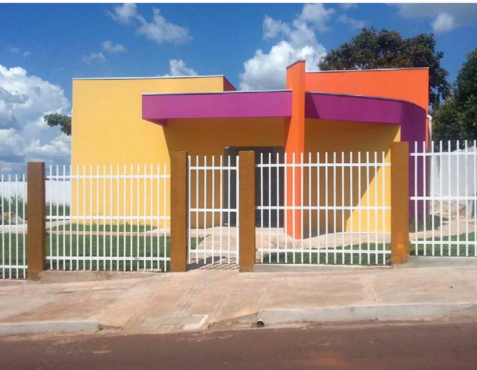
Creas do Jardim Shangri-lá está com as obras praticamente finalizadas
