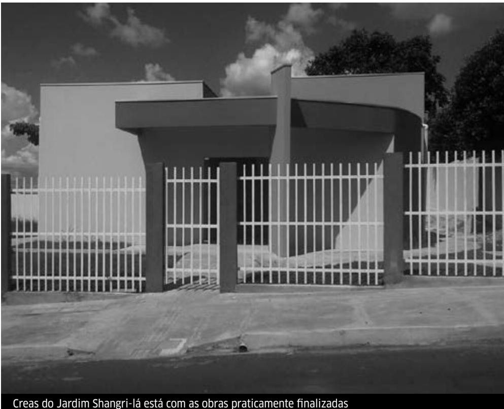
Creas do Jardim Shangri-lá está com as obras praticamente finalizadas
