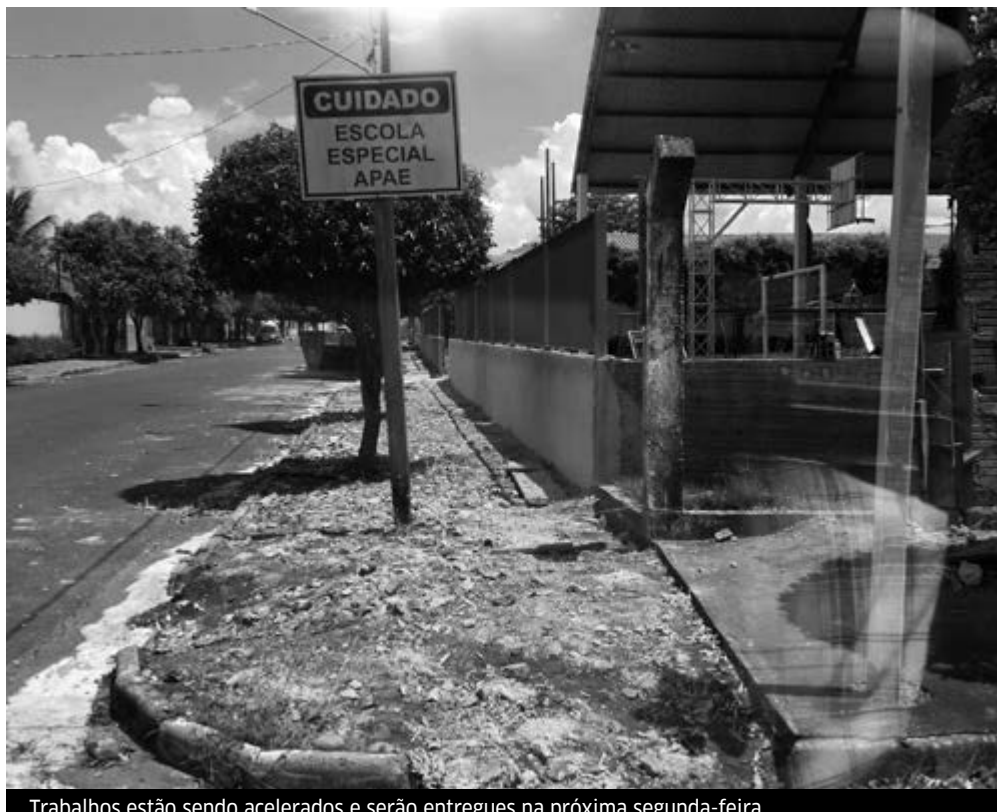
Trabalhos estão sendo acelerados e serão entregues na próxima segunda-feira
