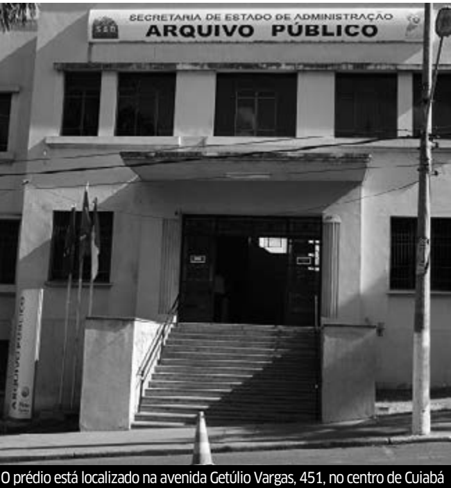
O prédio está localizado na avenida Getúlio Vargas, 451, no centro de Cuiabá
