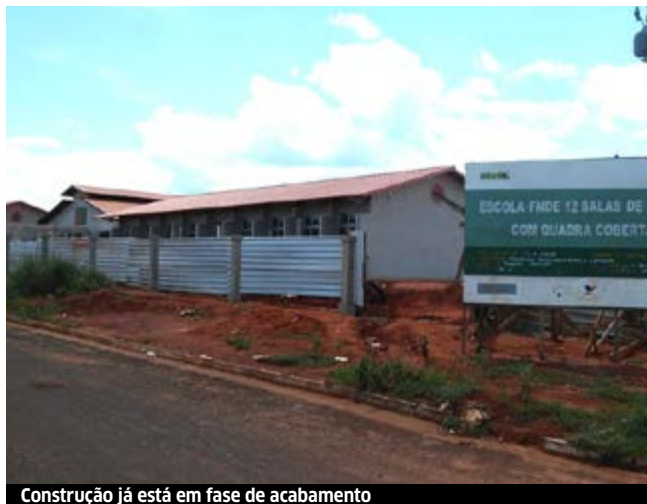
Construção já está em fase de acabamento
