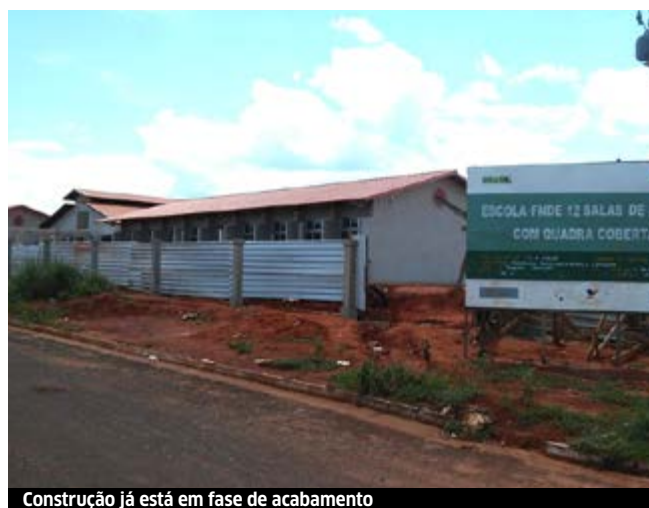
Construção já está em fase de acabamento
