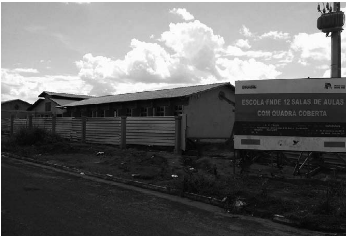
Construção já está em fase de acabamento
