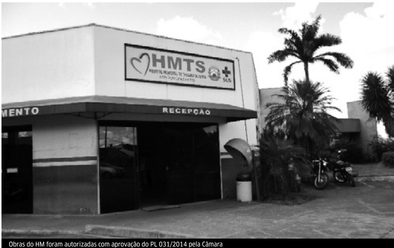
Obras do HM foram autorizadas com aprovação do PL 031/2014 pela Câmara
