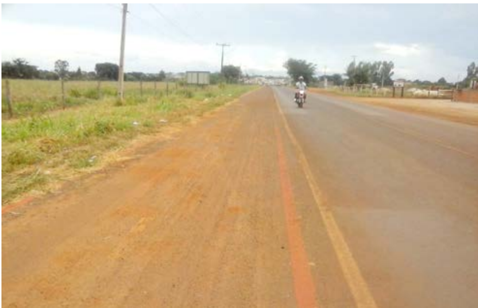
De acordo com Betoni, já aconteceram acidentes no local, por isso os moradores solicitam as melhorias
