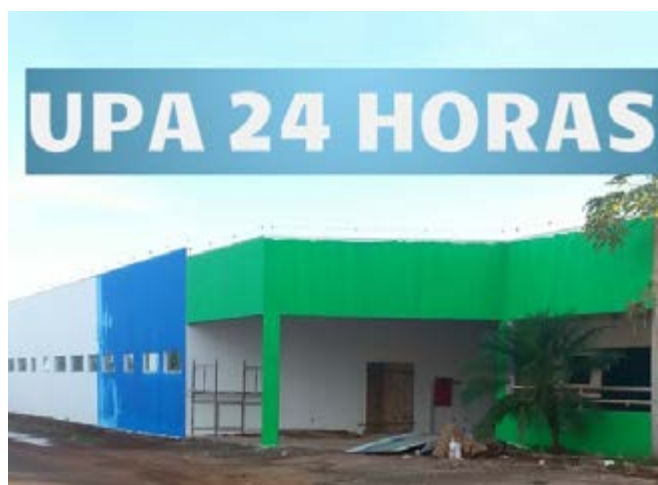
As obras estão praticamente 96% concluídas
