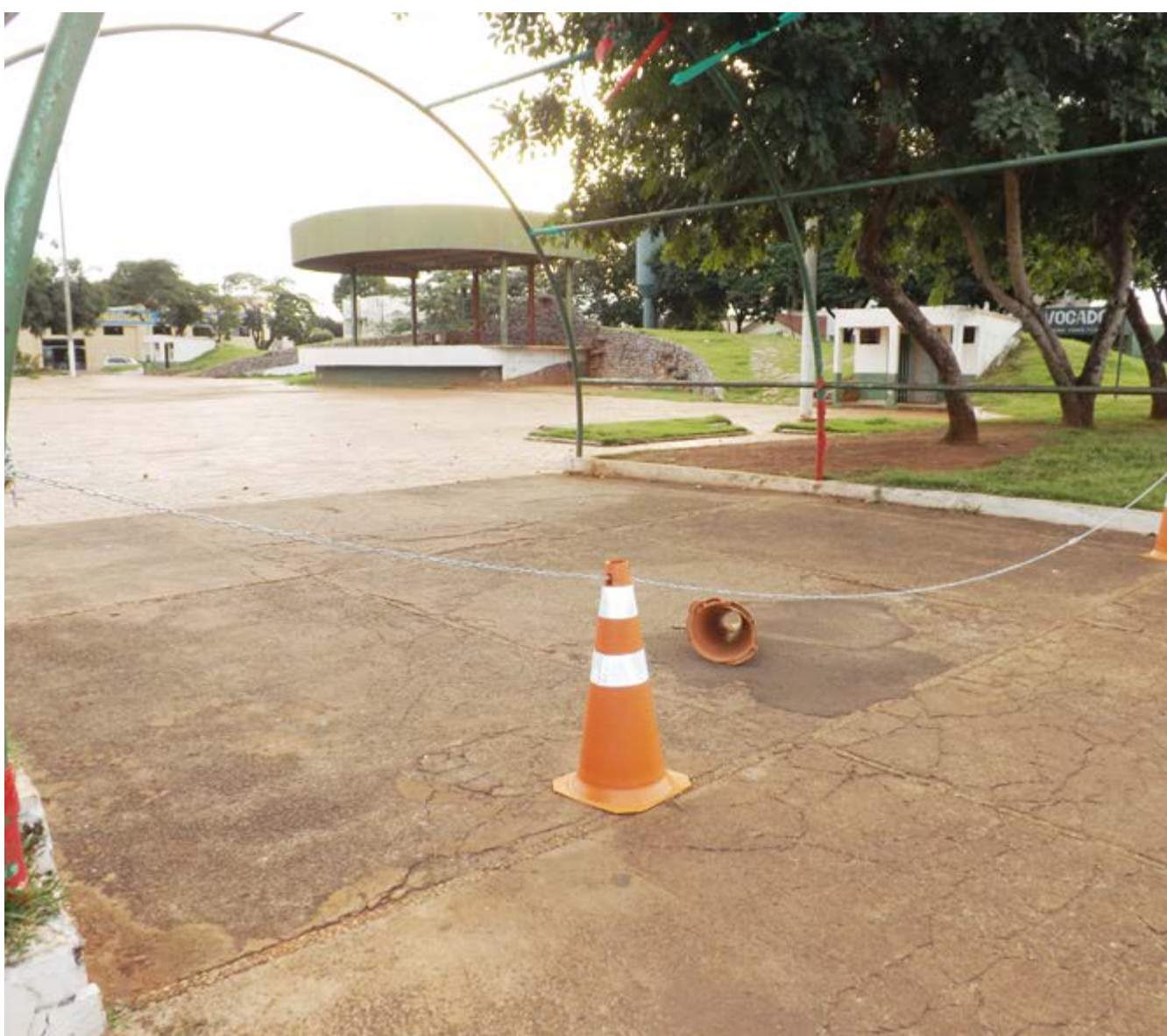
Na Praça dos Pioneiros - ponto de maior problema, o Executivo Municipal proíbe a entrada de veículos com correntes
