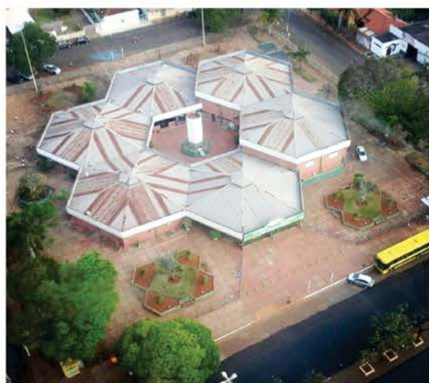
Título: Centro Cultural visto de cima Fotógrafo: Alexandre Rolim Local: Avenida Brasil - Centro
