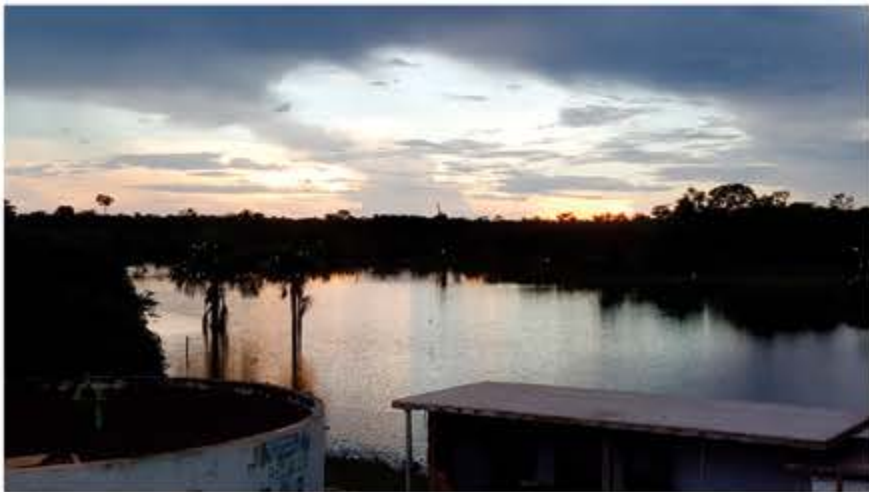
Título: Por do sol no queima pé Fotógrafo: Rafael Grigulo Local: Estação de Tratamento de Água Queima Pé
