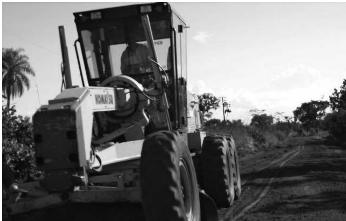
O projeto visa atender aos anseios da população, especialmente utilizam essas estradas vicinais e carregadores
