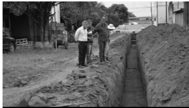
Obras em andamento
