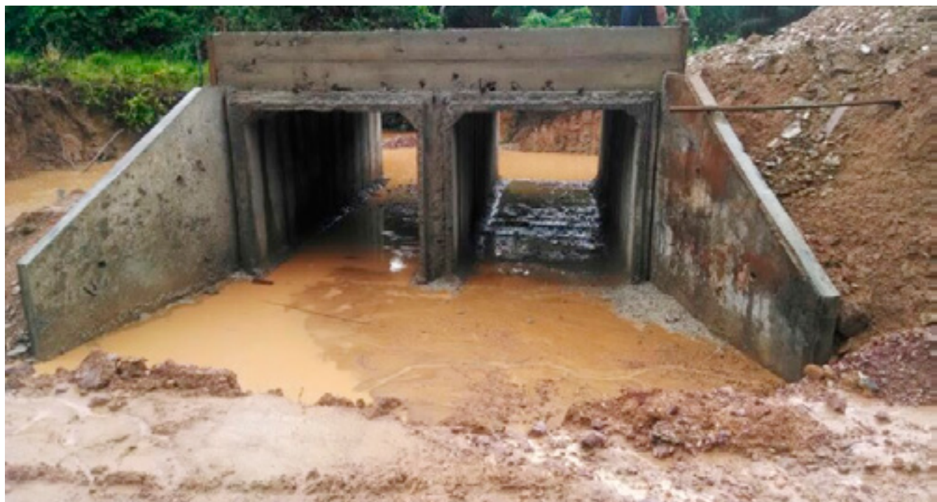
Pontes de madeira estão sendo substituídas por bueiros celulares
