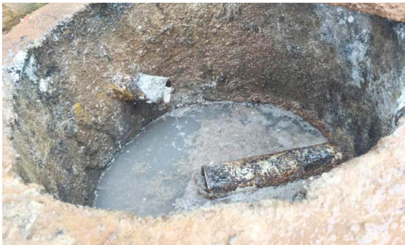
70% das caixas de gordura das residências estavam irregulares
