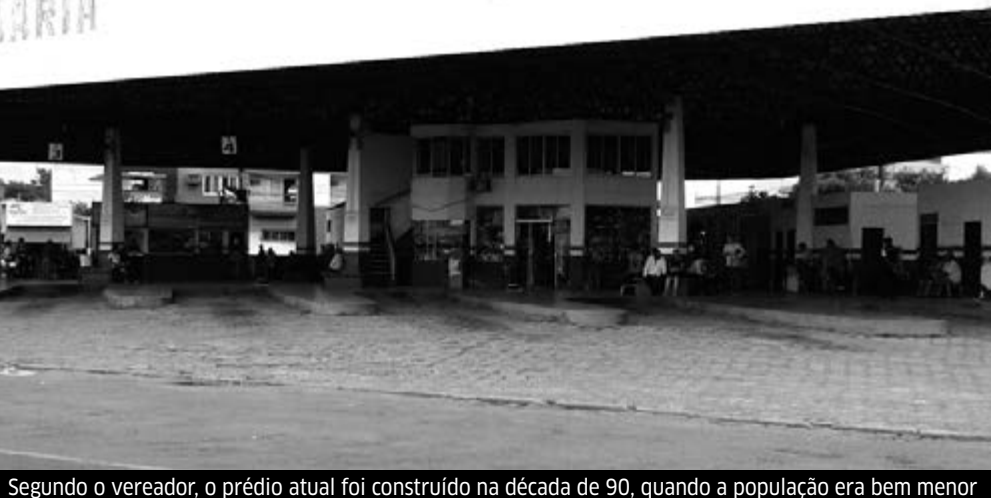
Segundo o vereador, o prédio atual foi construído na década de 90, quando a população era bem menor
