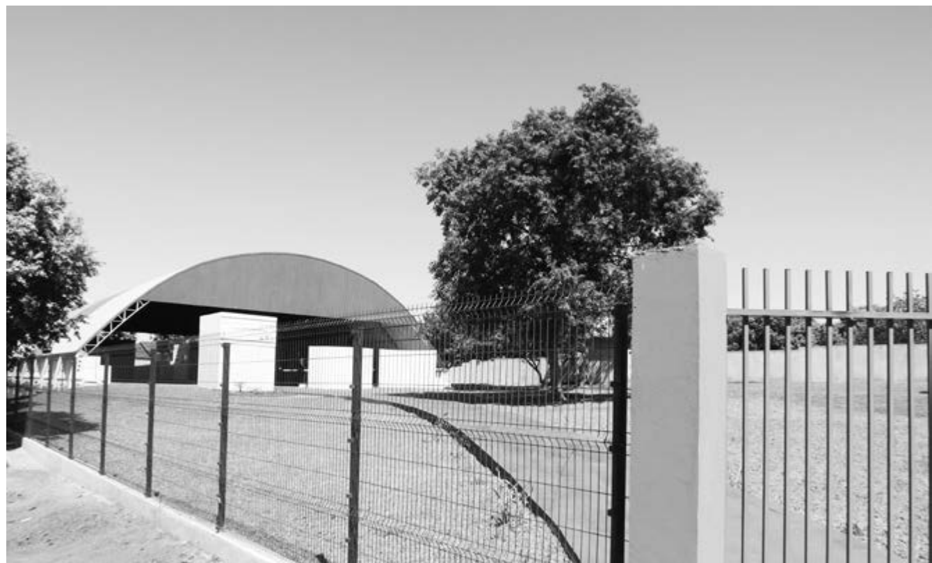
O espaço ganhou refeitório, cozinha, despensa, banheiros, escritório e um espaço amplo e coberto para atividades coletivas
