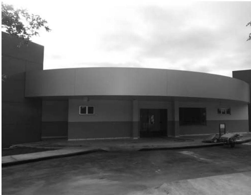
Os serviços estão praticamente finalizados, faltando apenas alguns ajustes na área externa
