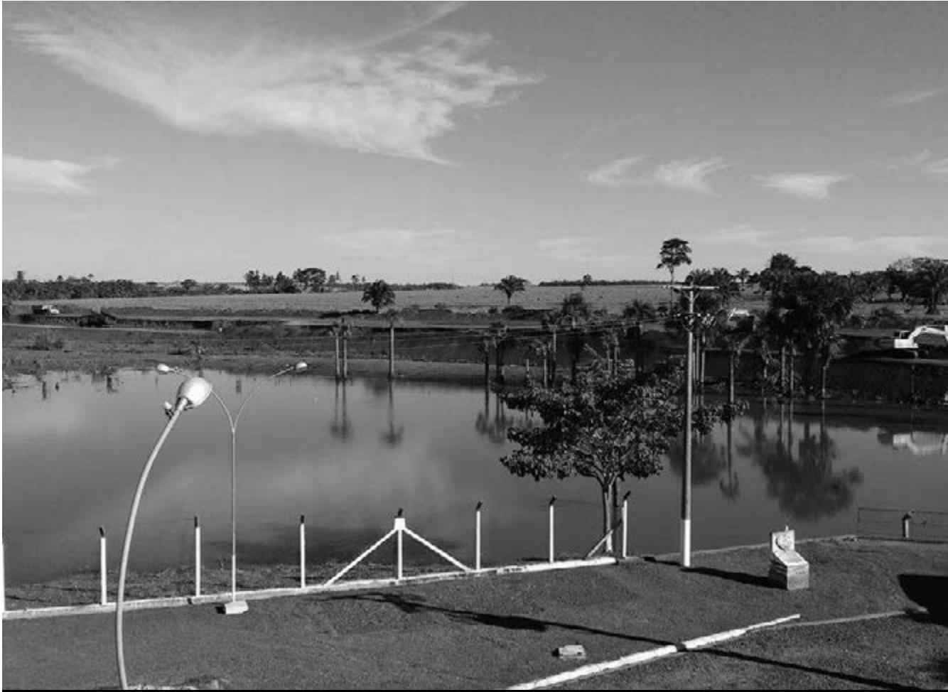
Novo reservatório de água está sendo construído ao lado da atual represa de captação
