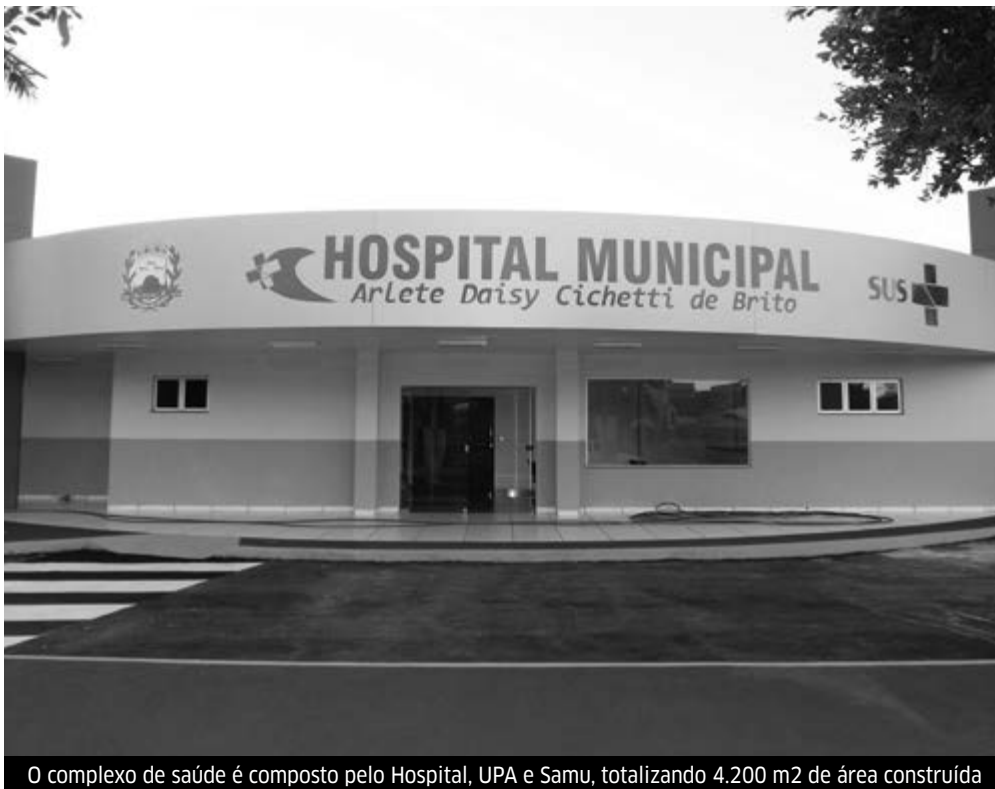
O complexo de saúde é composto pelo Hospital, UPA e Samu, totalizando 4.200 m2 de área construída
