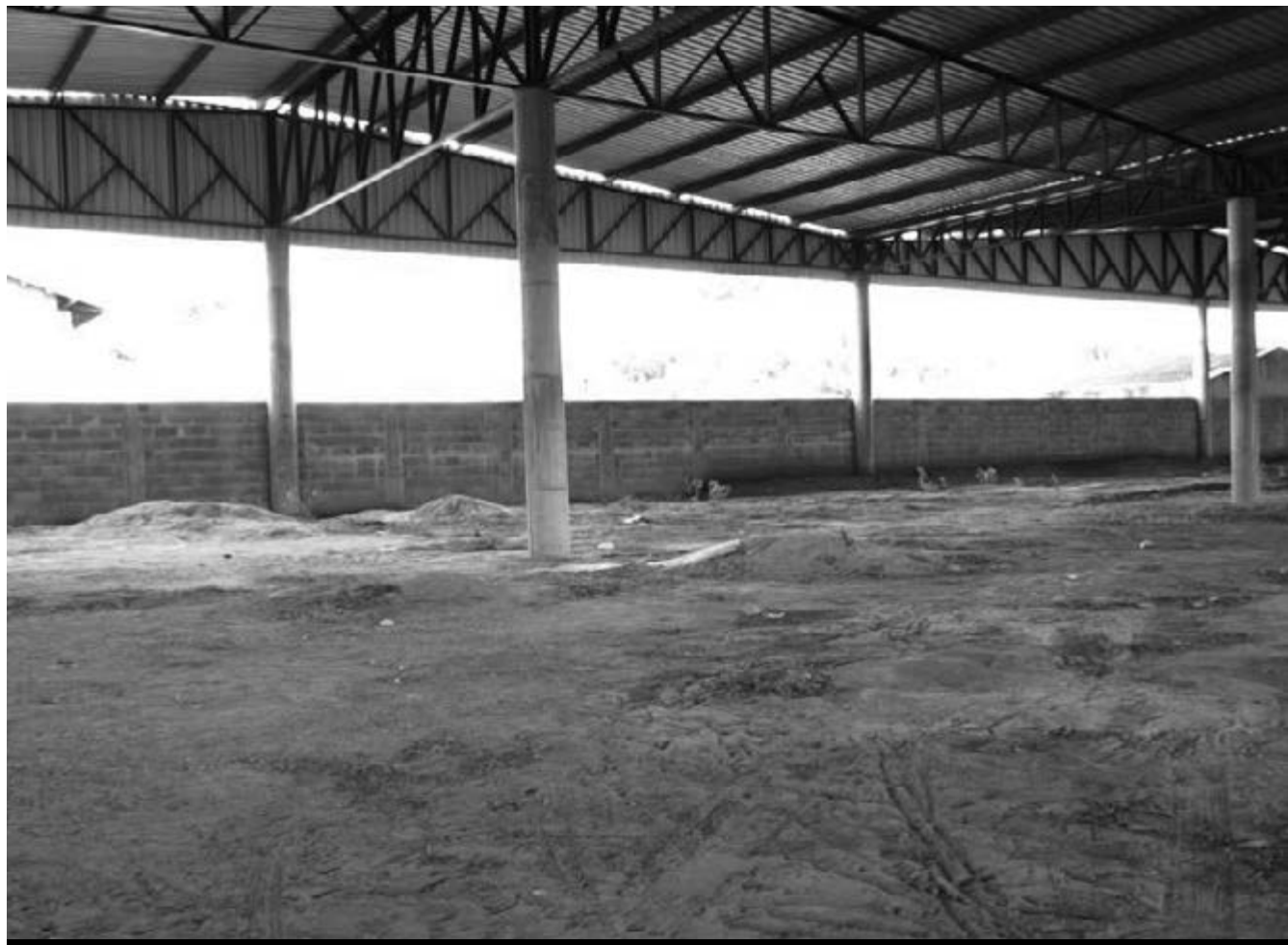
Após o prazo de licitação, obras serão retomadas imediatamente
