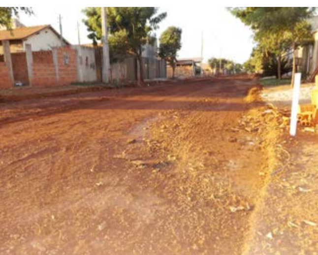
As obras no local serão finalizadas dentro dos próximos 20 dias
