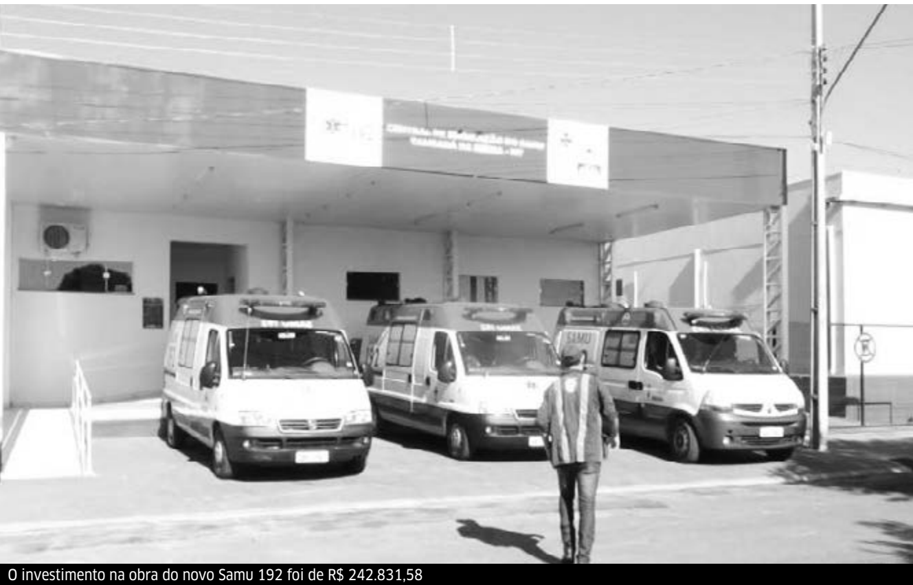
O investimento na obra do novo Samu 192 foi de R$ 242.831,58
