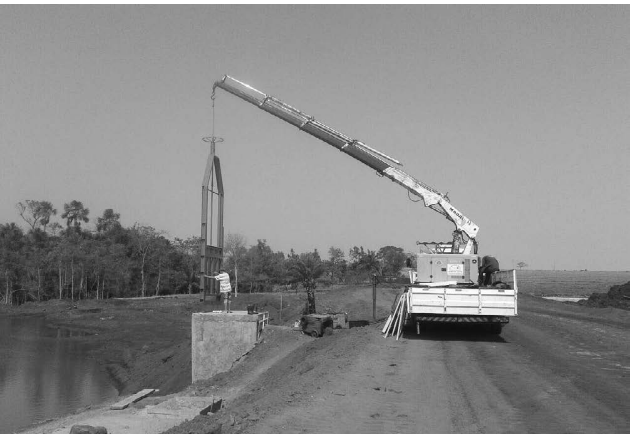
Ampliação da ETA, orientações sobre uso racional; Samae tenta controlar situação
