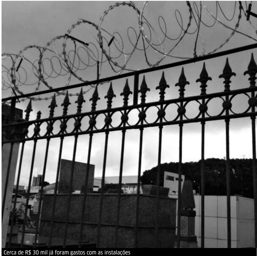
Cerca de R$ 30 mil já foram gastos com as instalações
