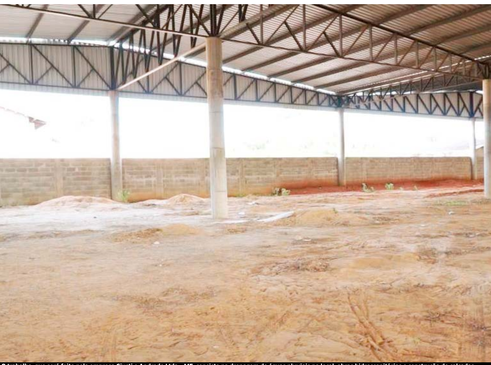
O trabalho, que será feito pela empresa Giusti e Andrade Ltda - ME, consiste na drenagem de águas pluviais no local, obras hidrossanitárias e construção de calçadas
