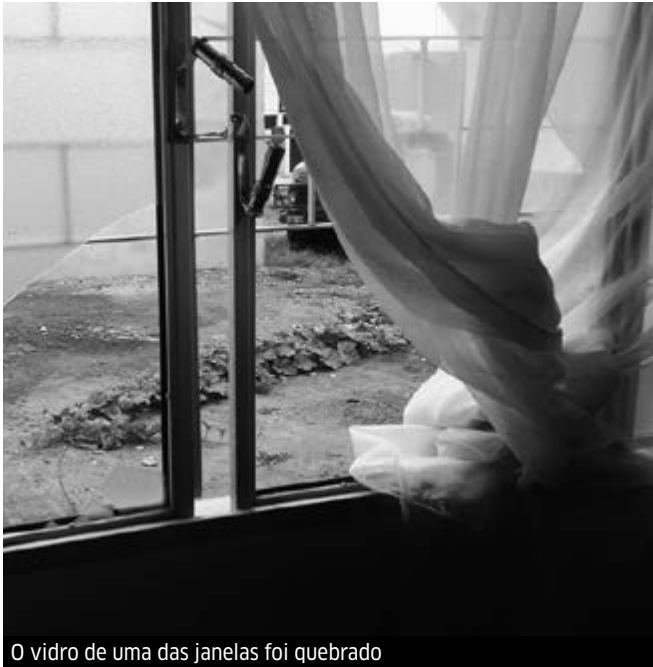
O vidro de uma das janelas foi quebrado
