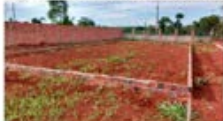
Estrutura para Quadra de areia
