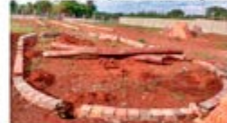
Estrutura para Palhoça
