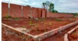
Estrutura para Duas Piscinas
