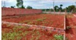
Estrutura para Quadra de areia
