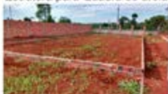
Estrutura para Quadra de areia
