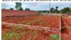
Estrutura para Quadra de areia
