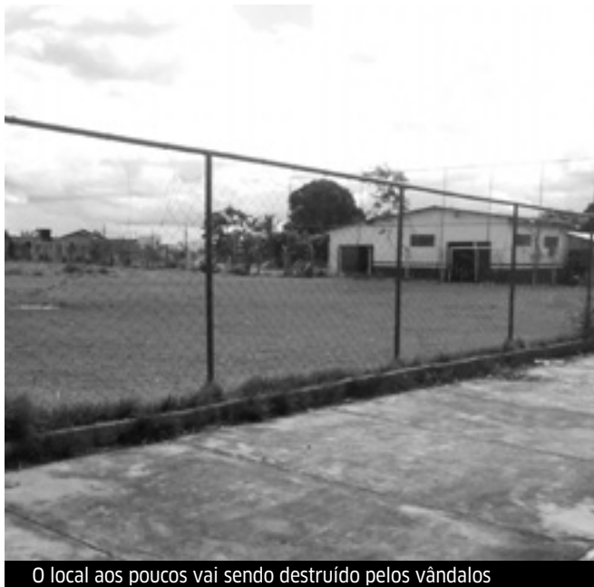
O local aos poucos vai sendo destruído pelos vândalos
