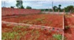
Estrutura para Quadra de areia
